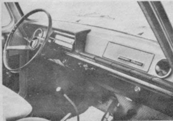
T v: De ljusa ytorna på instrumentbrädan har imiterat trämönster. Resten är klätt med svart galon.
